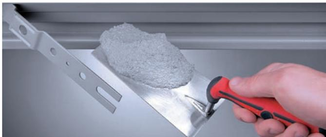
Nel caso di fissaggio con zanche, si consiglia di creare gli scassi adeguati nella parete (sezione 80 x 160 mm) oppure di fissare le zanche con tasselli. Le zanche vanno ripiegate e bloccate nella parete. Ai fini di una buona tenuta meccanica si consiglia di riempire il vuoto tra telaio e muratura con malta cementizia oppure con schiuma poliuretanic.
